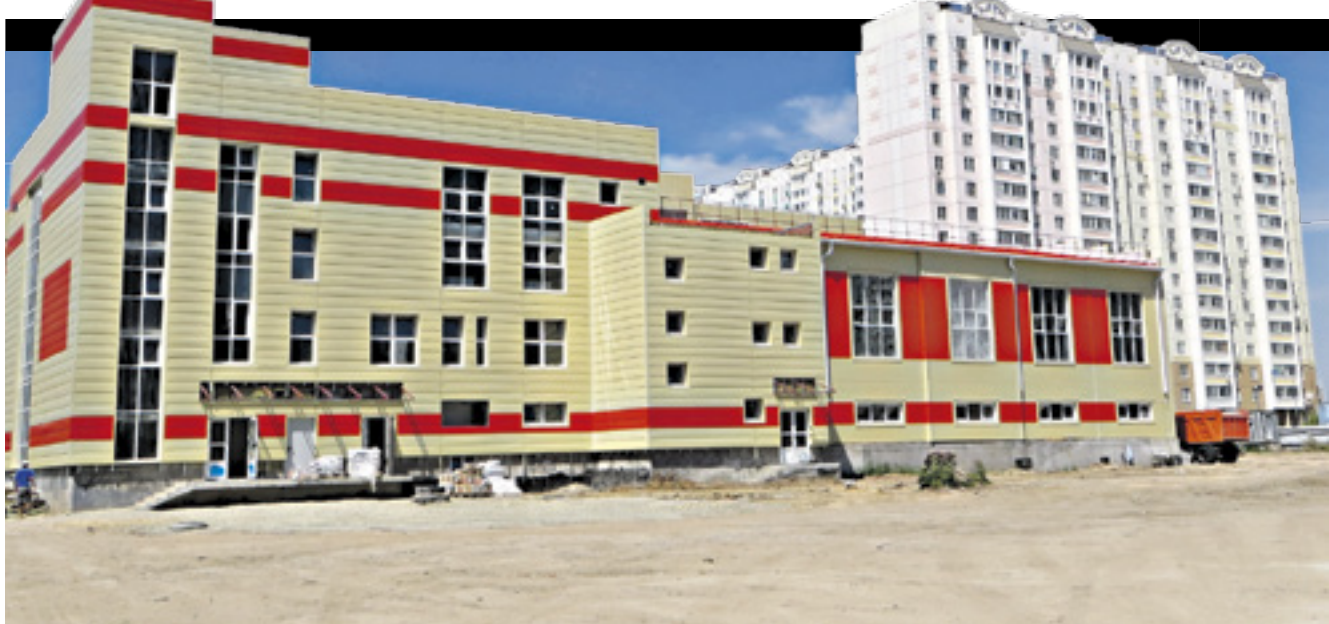
Идет строительство школьного комплекса в Левенцовском районе
